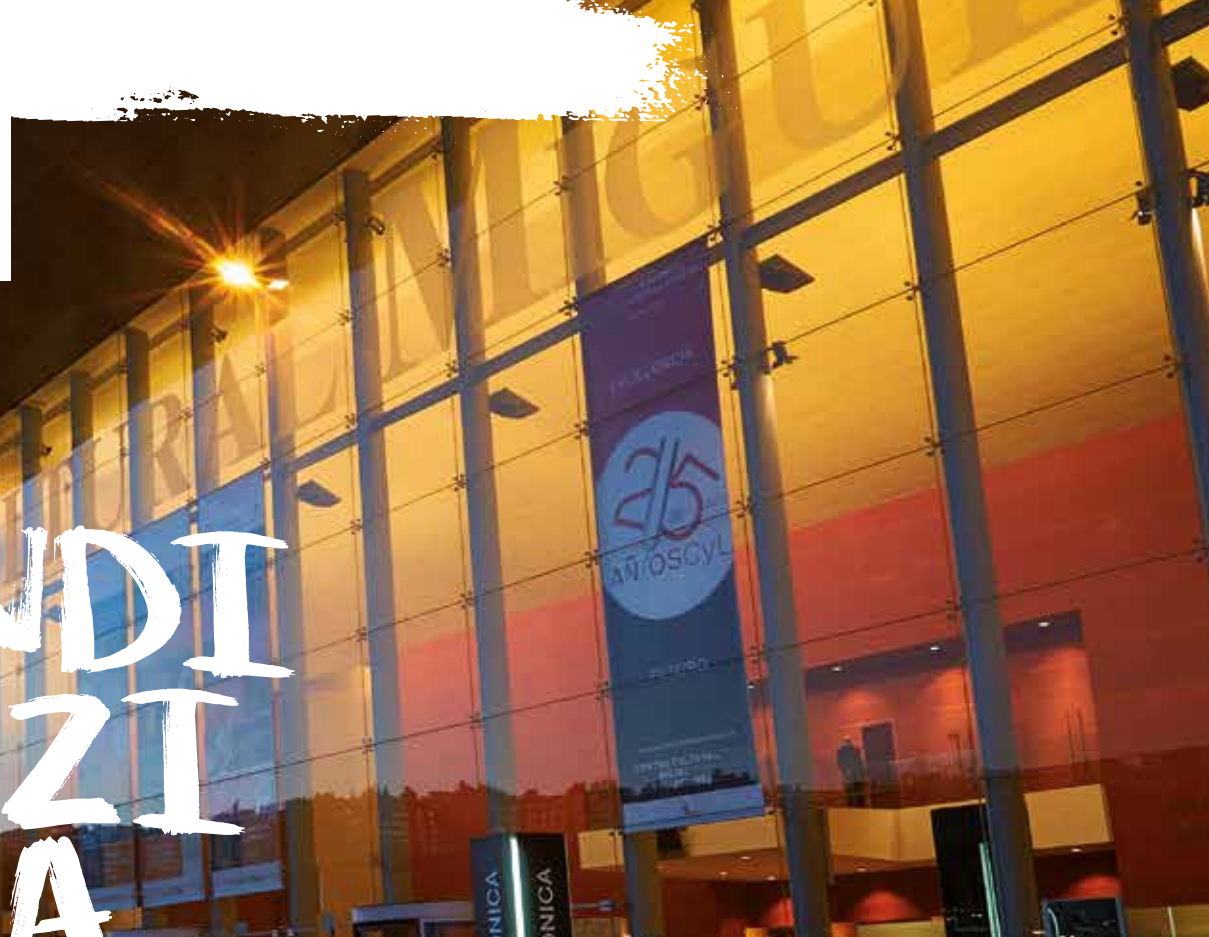
Facciata principale del Centro culturale Miguel Delibes. Valladolid.
