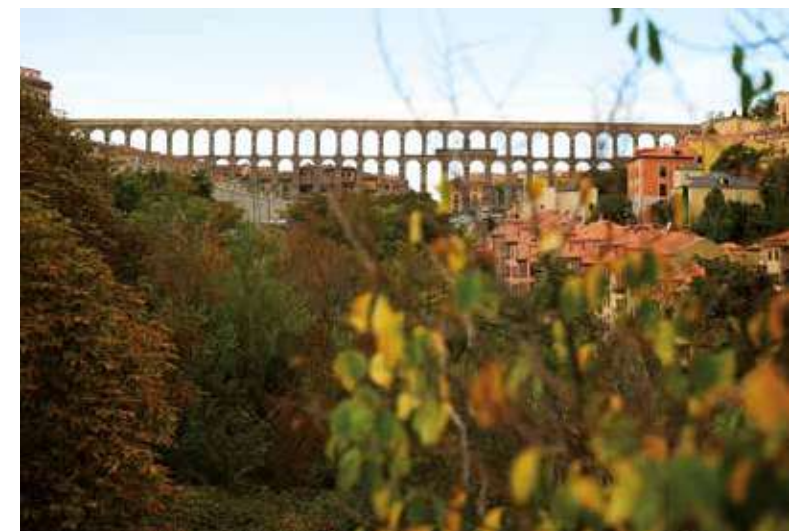
Acueducto de Segovia. / Aqueduct of Segovia.
