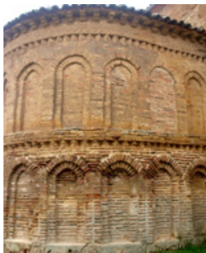
Iglesia de Santo Tomás (ábside)
