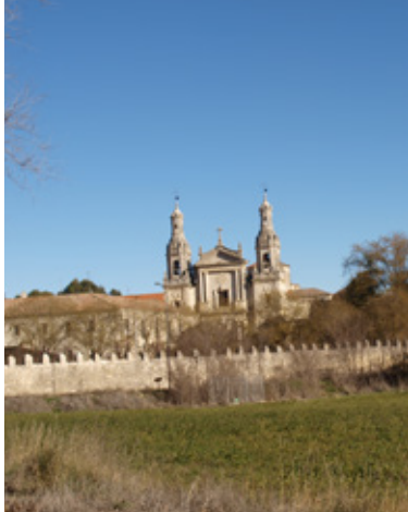
Monasterio de La Santa Espina desde la Cerca-Muralla
