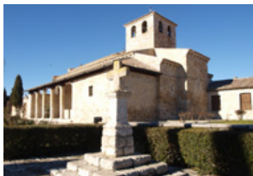
Iglesia de Santa María. Vista general.
