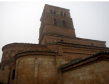
Abside de la iglesia del Monasterio
