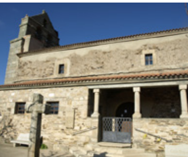
Iglesia de San Mamés (Bermillo de Alba)
