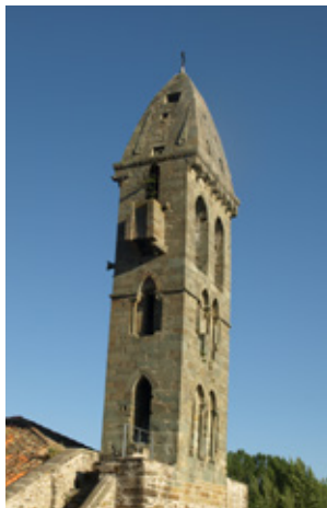
Torre románica de la iglesia de Santa María
