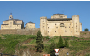
Vista general con castillo e iglesia
