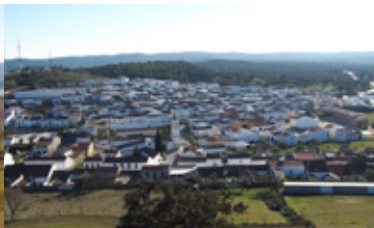
Vista panorámica de El Real de la Jara
