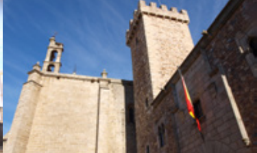
Torre de la casa de los Cáceres-Ovaldo
