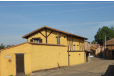
Typisches Gebäude in Chozas de Abajo
