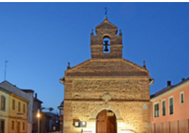
Santiago-Wallfahrtskirche in Trobajo del Camino
