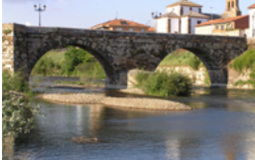
Brücke über den Órbigo
