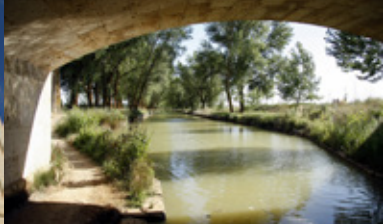
Kanal von Kastilien
