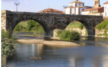
Ponte sobre o rio Órbigo
