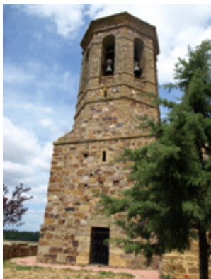
Turm der Kirche Santa Marina
