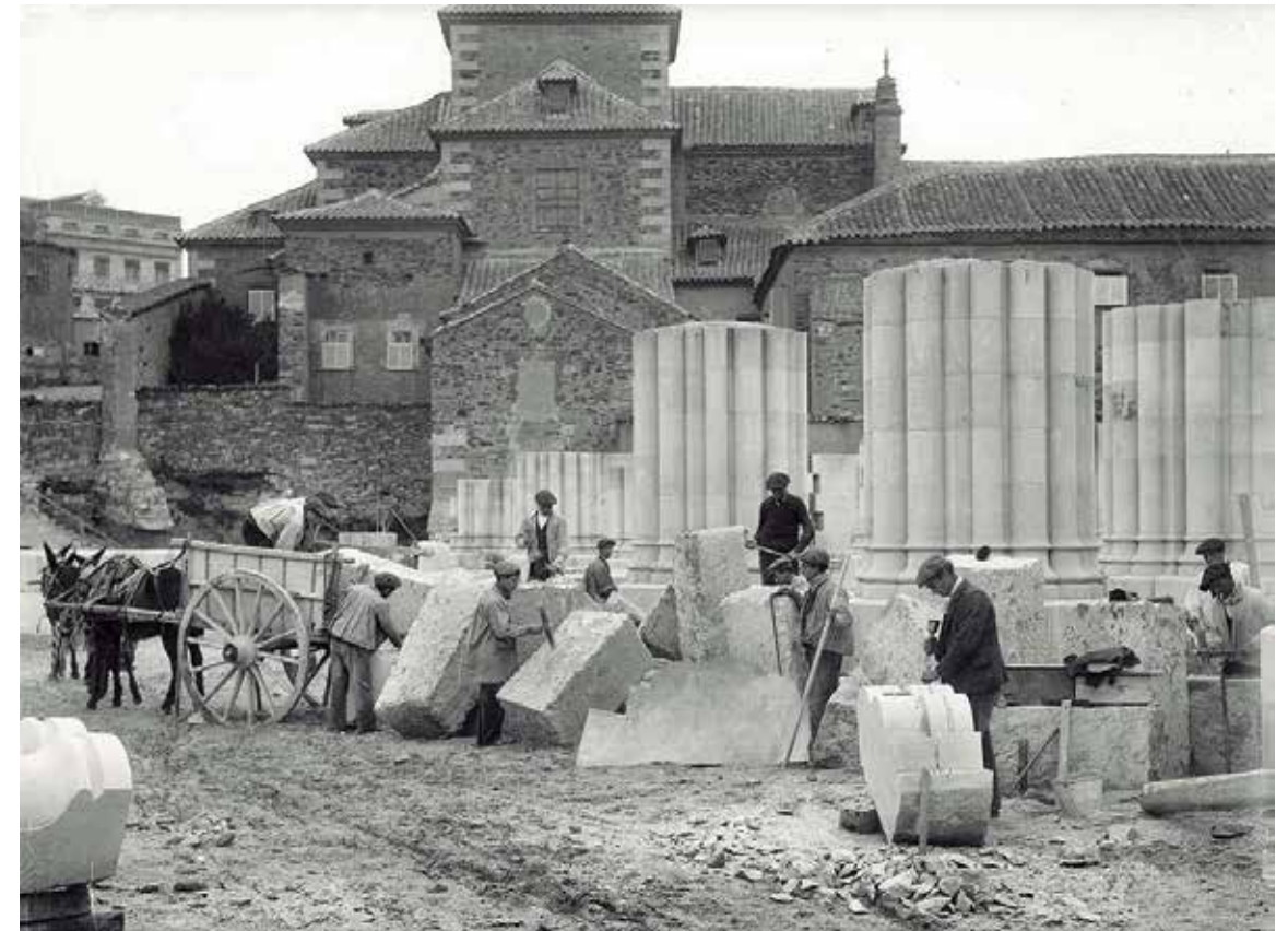
Basílica Teresiana en construcción
