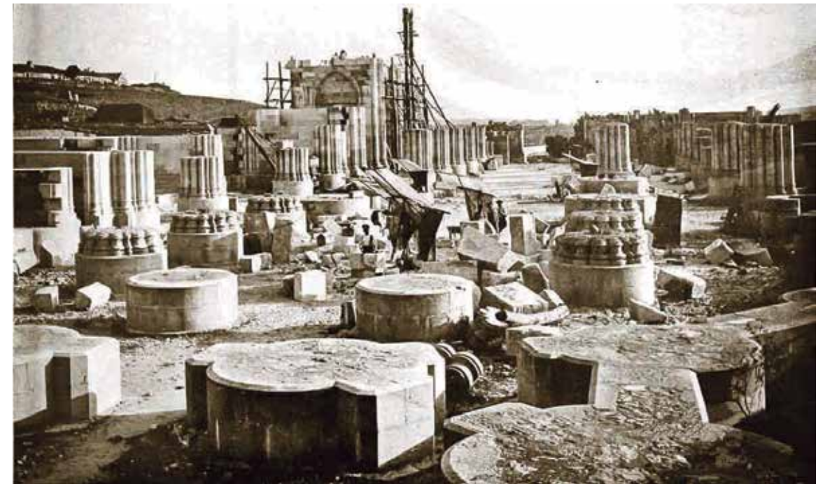
Basílica Teresiana en construcción
