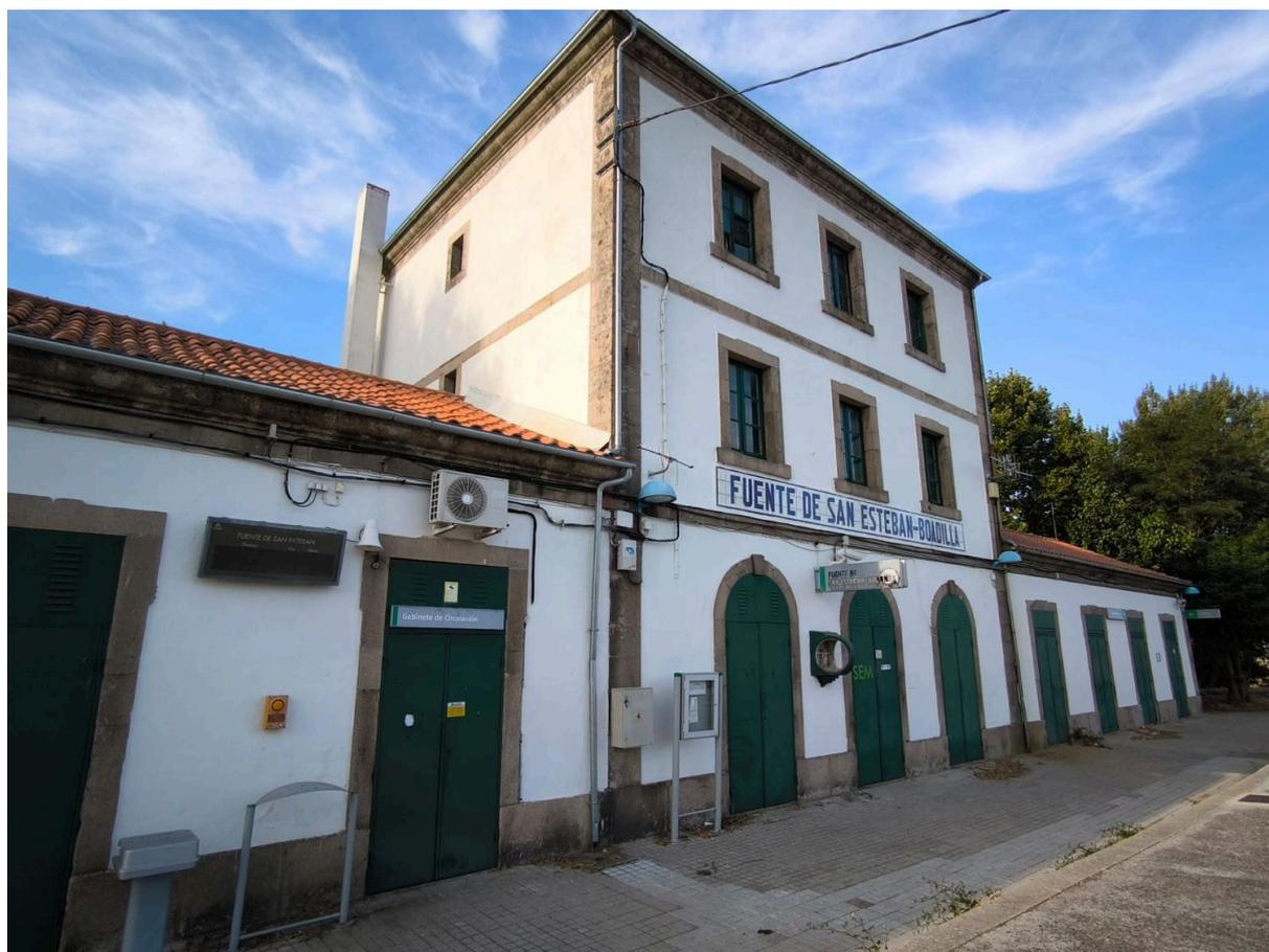
La arquitectura de estas estaciones es bien humilde, destacando mínimamente las de las cabeceras. La de Boadilla-La Fuente se compone de tres cuerpos, los extremos de planta baja y de tres pisos el central. Todas sus puertas y ventanas son adintelados, excepto las tres puertas del cuerpo principal, que llevan arcos.
